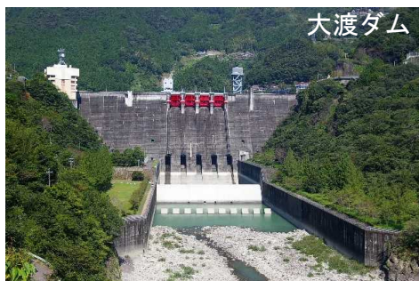
▲既設ダムの有効活用
