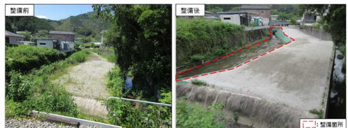
水路の整備（岡花地区）
