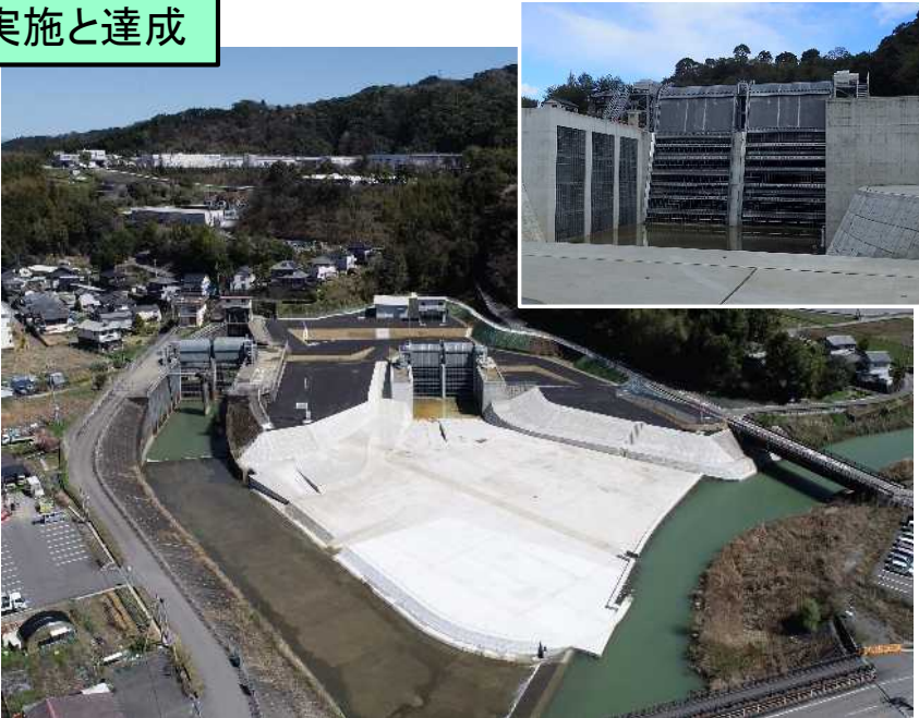
新日下川放水路呑口
