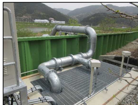
雨水排水ポンプの整備
