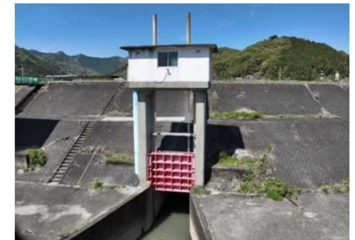
派川日下川放水樋門
