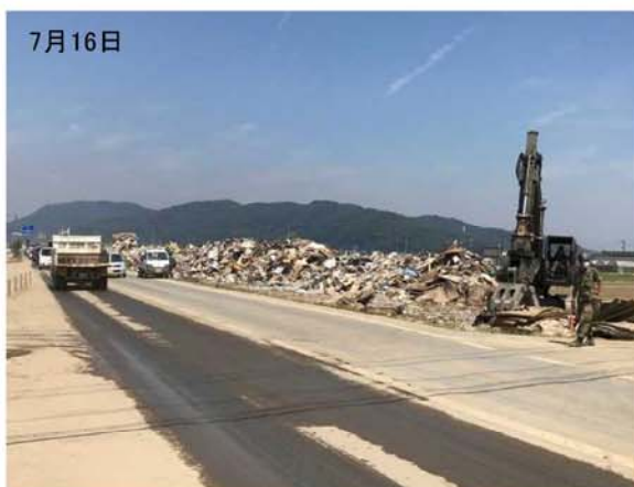
【岡山県倉敷市】 国道486号線付近
