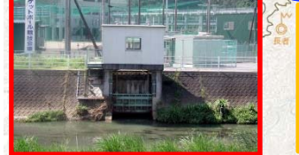
呑吞雨水貯留浸透施設(いの町)
