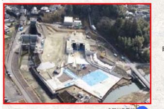
放水路整備(日下川新規放水路)
