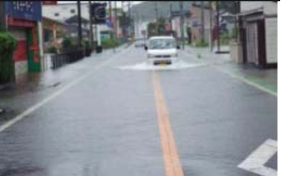
②国道33号の冠水
