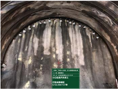
小口径長尺先受工法 (AGF工法)
