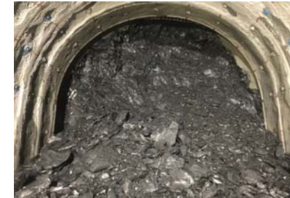
切羽天端および鏡面崩落状況
