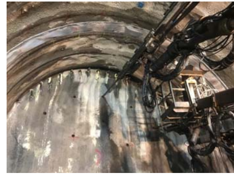
小口径長尺鋼管鏡補強工 (鏡ボルト)
