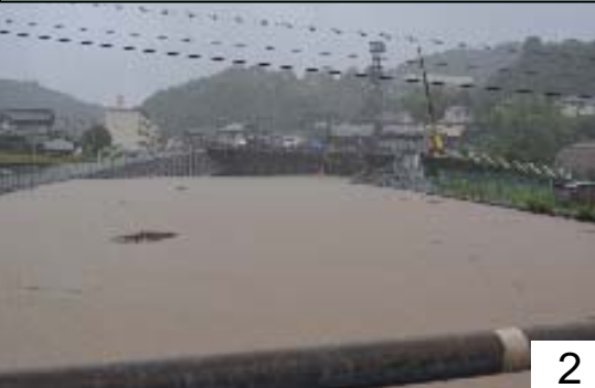
④日下川放水路(既設)の呑口
