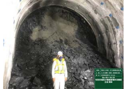
切羽天端および鏡面崩落状況
