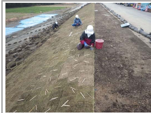
5 覆土・張芝の施工
