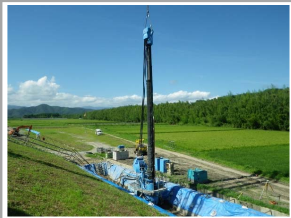
2 鋼矢板の打設
