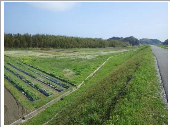
1 堤防拡幅 工事前
