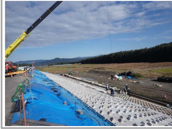
4 護岸ブロックの設置
