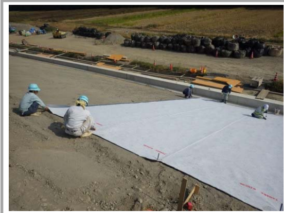
3 遮水シートの設置
