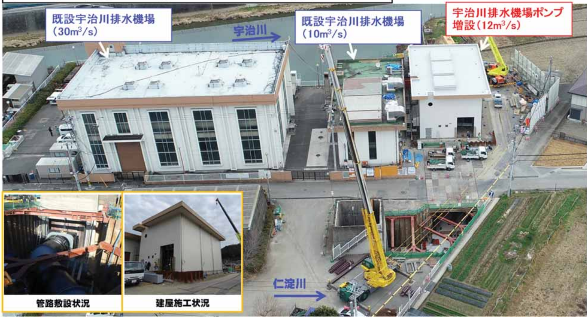
宇治川排水機場ポンプ増設(+12m 3 /s)空撮写真(H30.12.18)
