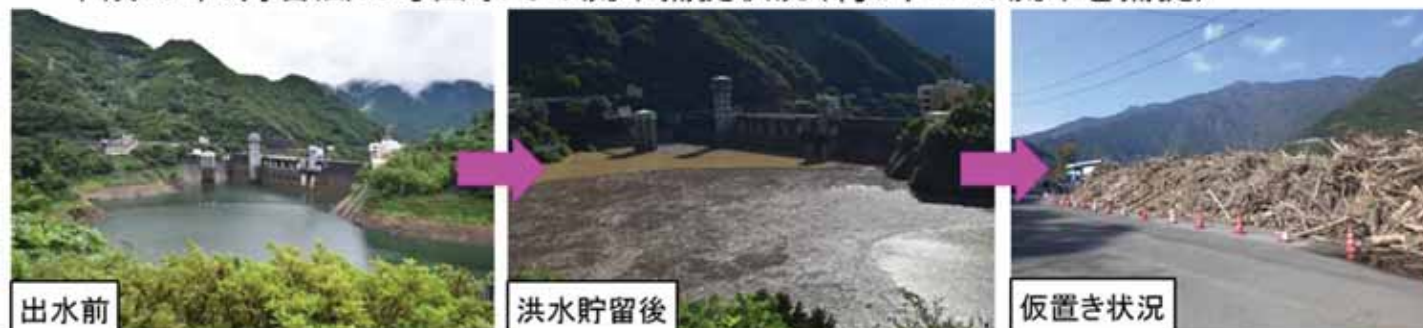
平成29年9月台風18号出水での流木捕捉状況（約5千 m^3 の流木を捕捉）
