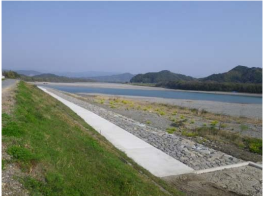
H26年度 新居箇所 施工直後
