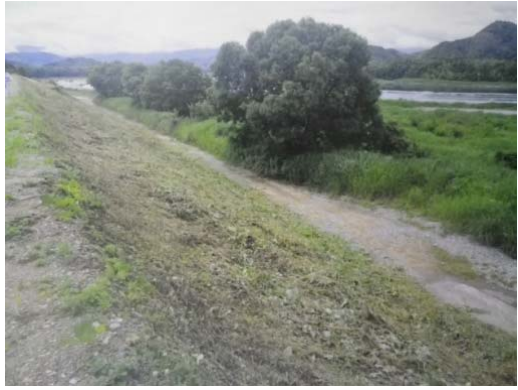
H26年度 新居箇所 施工前
