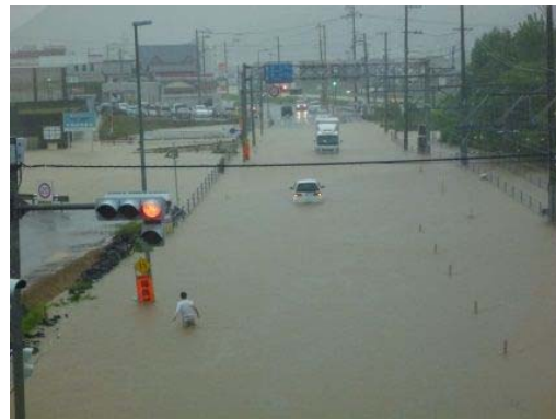
■国道33号冠水状況
