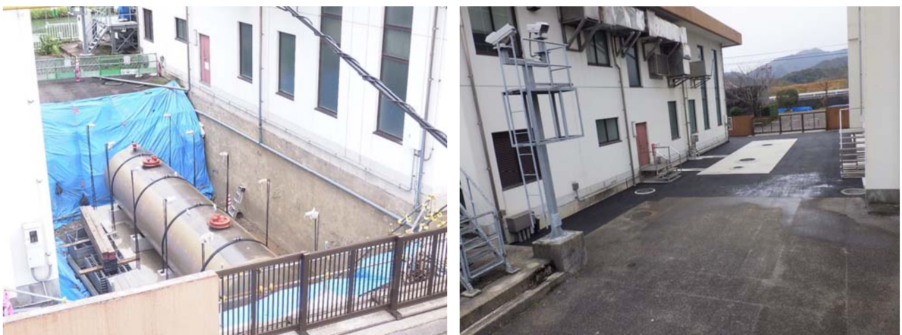
図 2.19 燃料タンクの施工状況（左写真：施工状況 右写真：設置後）
