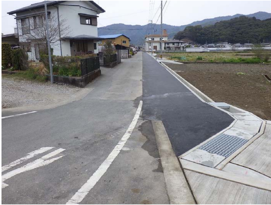
図 2.18 工事用進入路の完成状況
