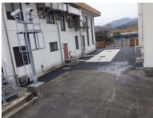
燃料タンクの設置完成状況
