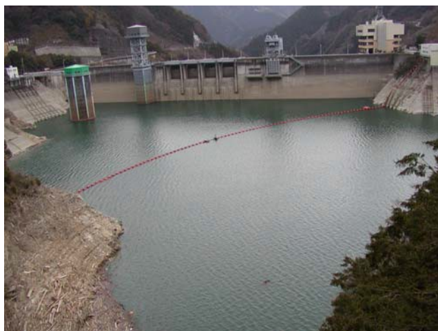
【大渡ダム(平成 17 年渇水)】
