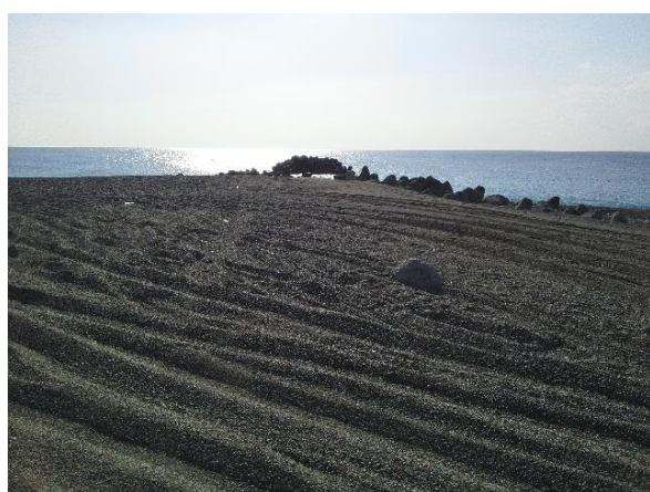
【河口導流堤の砂州堆積状況】
