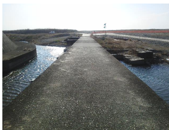
【河口導流堤根付け部の状況】
