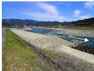
高水敷の造成（山田箇所9.2k付近）
