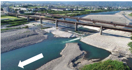
深淵床止め (H26年度 改修)
