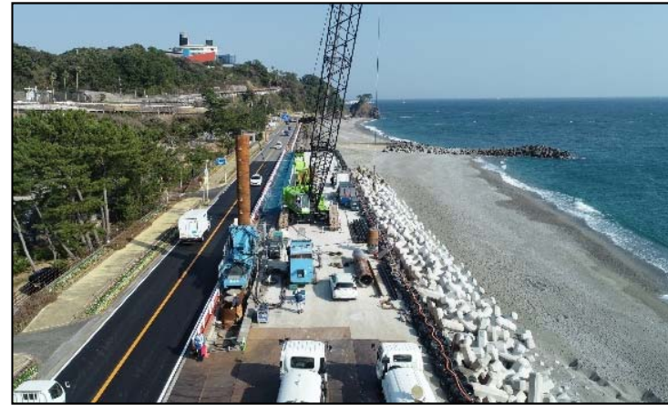
長浜工区の施工状況(鋼管杭工法)
