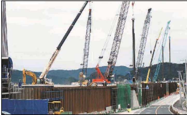
新居工区の施工状況(二重矢板工法)
