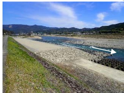
高水敷の造成(山田箇所9.2k付近)
