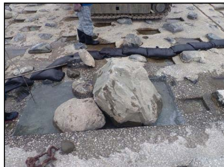
置石工(施工状況)
