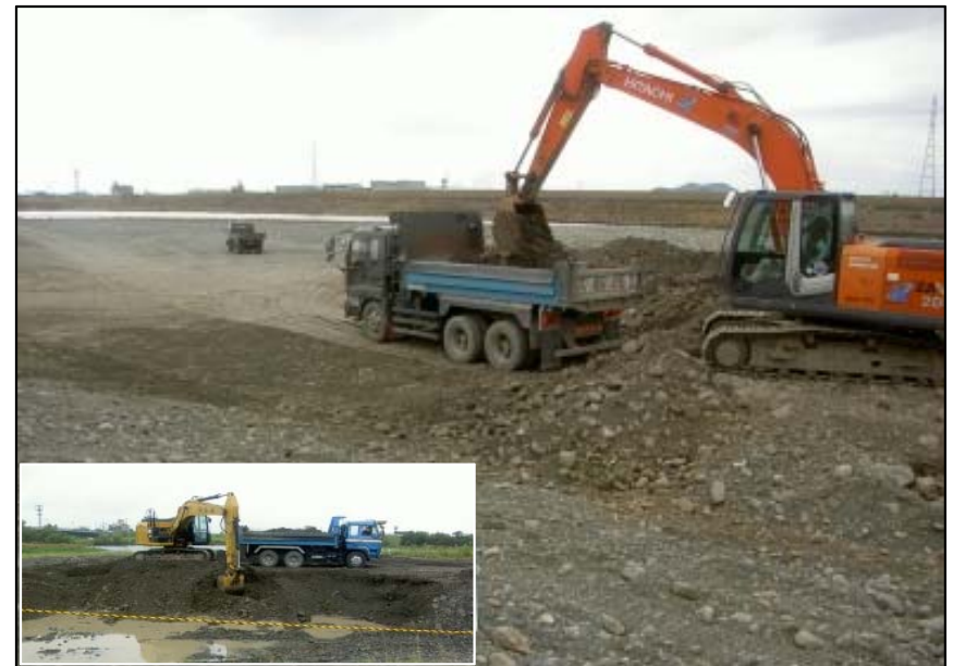
4k/0付近の河道掘削状況
