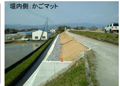
浸透対策(南国箇所4.2k付近)
