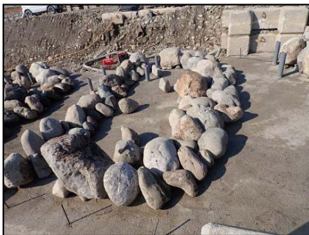
分散型落差工(施工状況)
