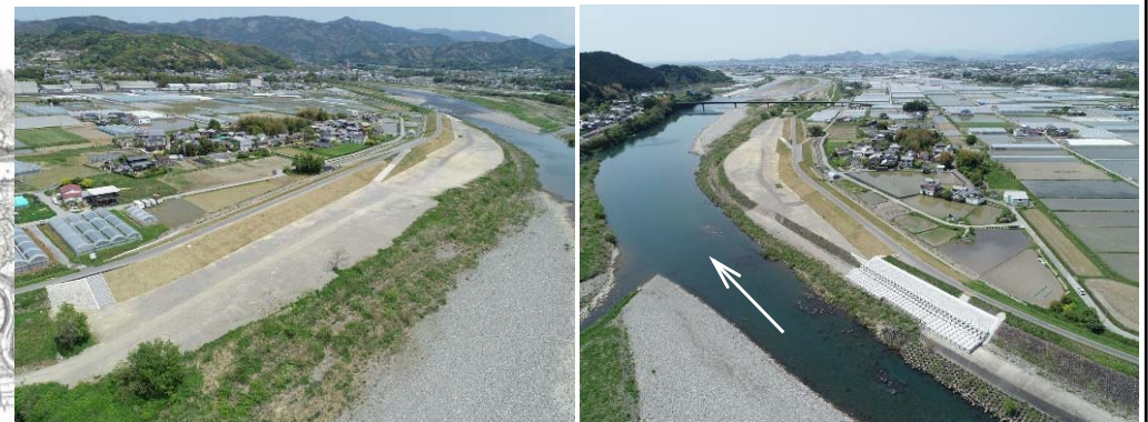
【下ノ村引堤完成写真】 (8k/6付近)
