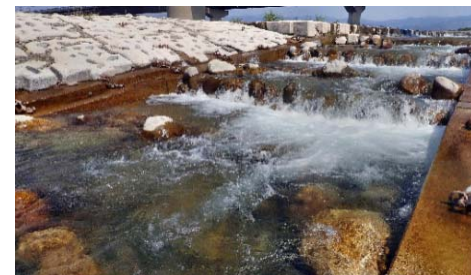
完成後の状況(開削水路)
