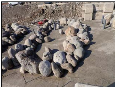
分散型落差工(施工状況)
