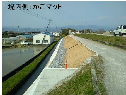
浸透対策(南国箇所4.2k付近)
