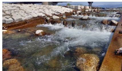
完成後の状況(開削水路)
