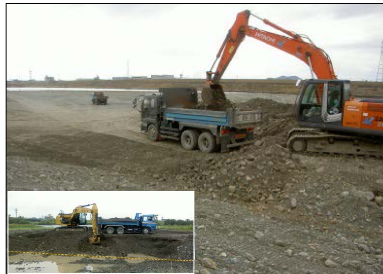
4k/0付近の河道掘削状況
