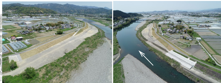
【下ノ村引堤完成写真】 (8k/6付近)
