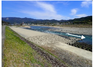
高水敷の造成(山田箇所9.2k付近)
