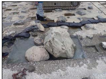
置石工(施工状況)
