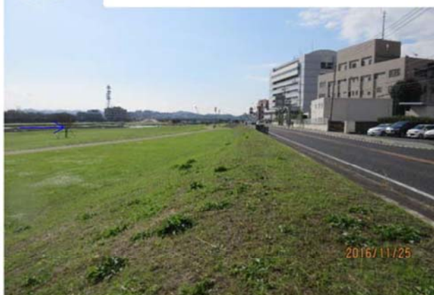
写真① 高水護岸を覆土で覆っている箇所
