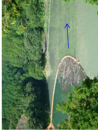
永瀬ダム分画フェンスの設置状況
