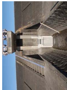
樋門のフラップ化工事 (京田樋門) 老朽化した構造物の補修 (深淵床止め)
