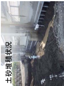
後川樋門前導水路の堆積土砂撤去：平成26年度
