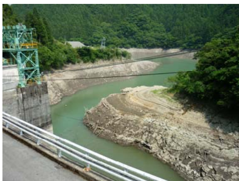
永瀬ダム貯水池の状況 (平成24年6月7日貯水率23.0%)
