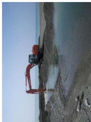
河口閉塞時の砂州の開削状況
