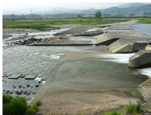
渇水時の統合堰の状況 (平成24年6月7日：河川整備計画策定後)
