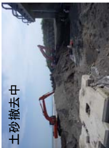
後川樋門前導水路の堆積土砂撤去：平成26年度
