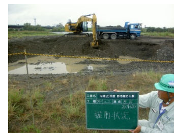
3K/4付近の河道掘削状況
