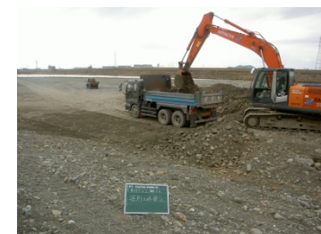
4K/0付近の河道掘削状況
