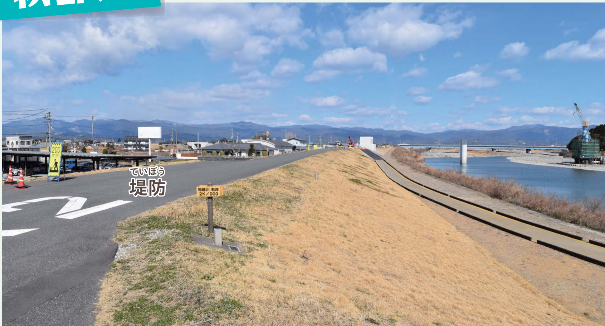
南国市 茨西地区 河口(海)から2.0kmのところ
