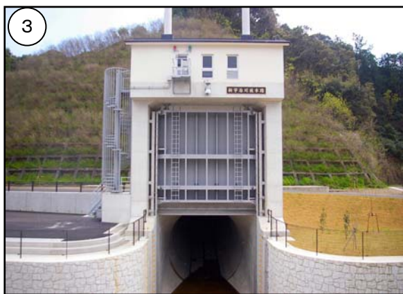
図 2.11 新宇治川放水路（呑口）
