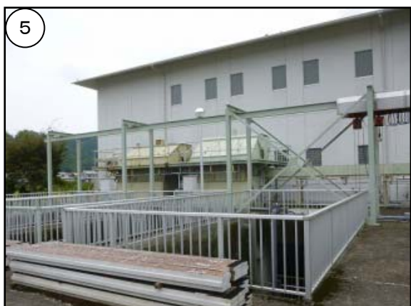
図 2.11 枝川雨水ポンプ場
