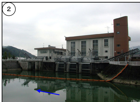
図 2.10 宇治川排水機場
