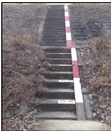
図 3.11 量水標の設置のイメージ
