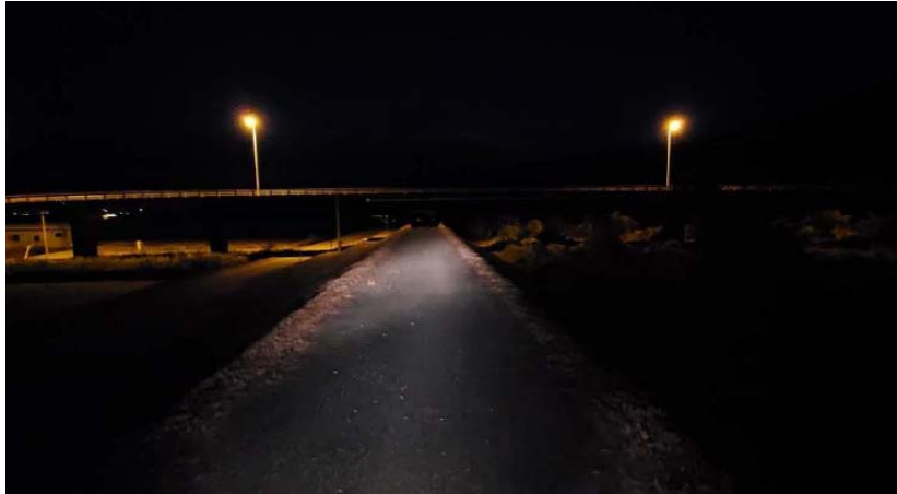
分岐点直進後の状況（事故発生時と同じ日没の約50分後に撮影）
