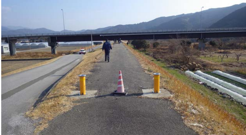
事故現場手前の状況（規制杭＋カラーコーン）
