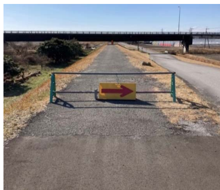
町田橋上流側（事故現場の反対側）の状況（バリケード）
