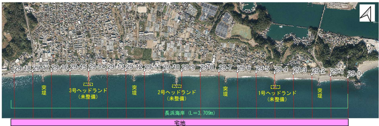
図 16 長浜海岸の施設・土地利用の状況
