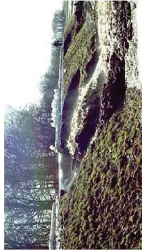
写真 - 10 堤防天端に達するすべりが発生した事例
