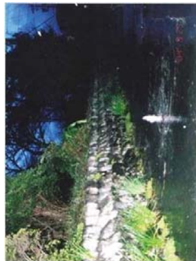
写真 - 4 法尻付近の堤内地から噴き上がる漏水
