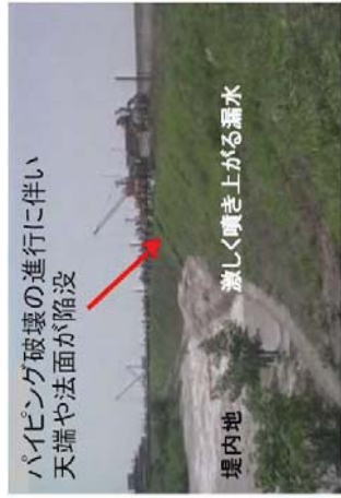
写真 - 9 激しく噴き上がる漏水によって天端や法面が陥没した事例
