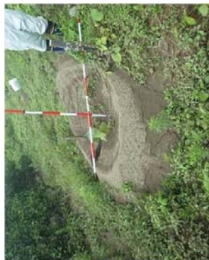
(b) 法尻付近で発見された噴砂を伴う漏水
