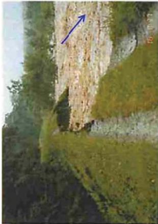
写真 - 11 天端まで侵食が進行した事例
