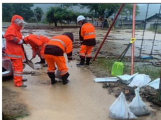
大江町河守地区 住宅敷地へ山水の流入を防ぐため土のうを設置
