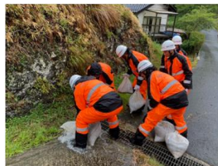
夜久野町末地区 水路の越水による道路冠水を防ぐため土のうを設置
