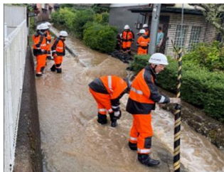
夜久野町額田地区 水路の越水を防ぐため土のうを設置
