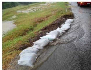
夜久野町直見地区 道路法面の洗掘を防ぐため土のうを設置
