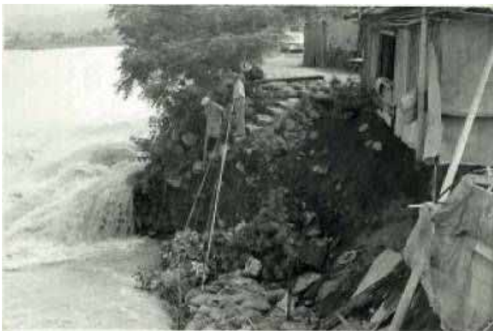
○昭和45年8月洪水 深淵流量: 約4,600m 3 /s(戦後最大) 左岸7k/0付近の河岸の侵食
