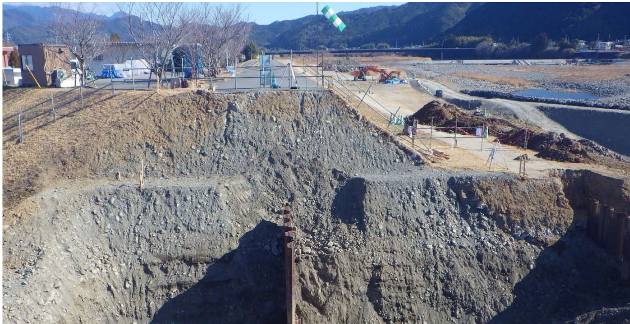
開削状況(全景)
