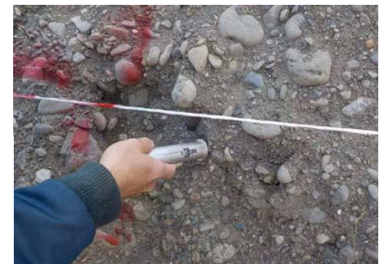
堤防調査状況
