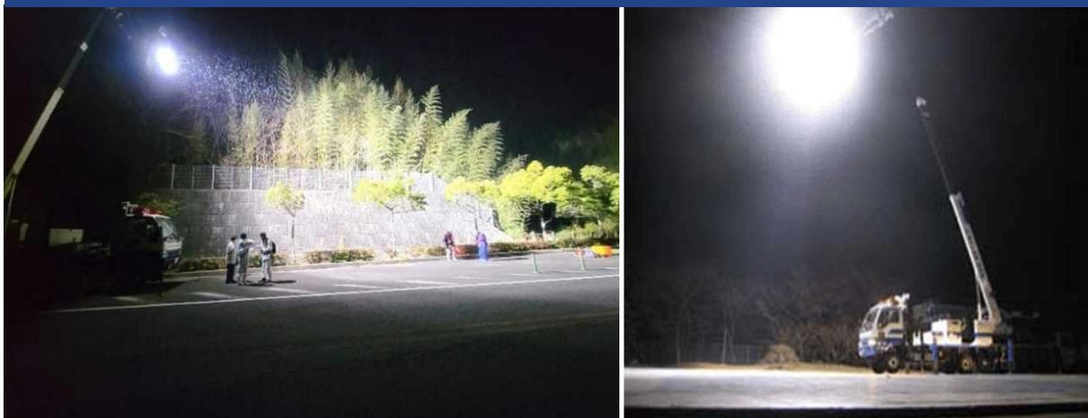
災害現場での応急復旧や危険箇所の監視、記録、情報活動等の作業を迅速かつ安全に施工するため夜間作業では、照明を確保します。また、監視カメラ（ITV）を設置し監視作業を行うことも可能です。
