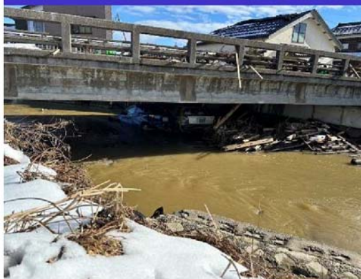
②津波遡上調査状況 (珠洲市)
