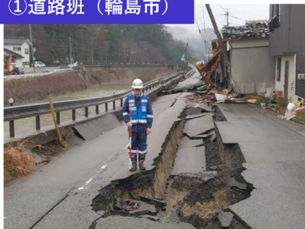
①道路班 (輪島市)
