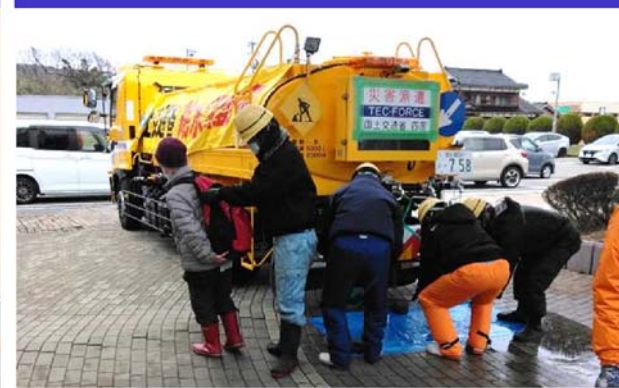
④給水支援の様子 (志賀町)
