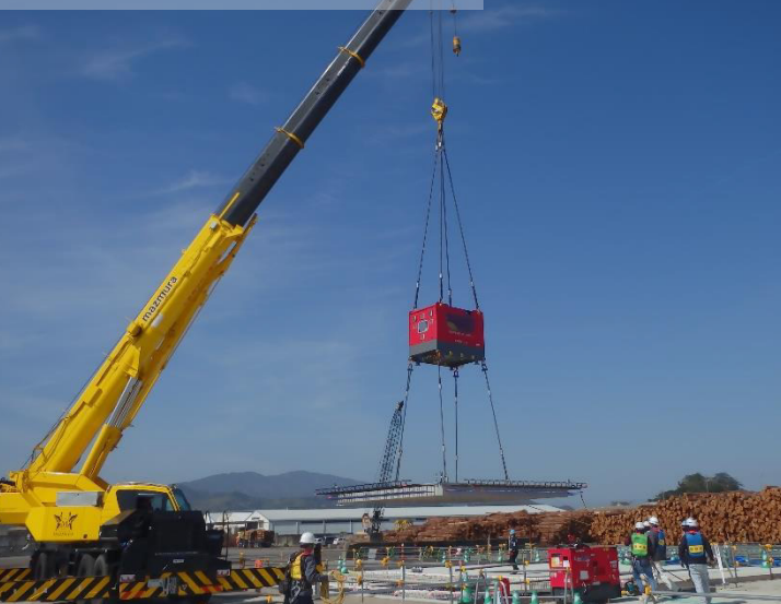
プレキャスト床板の据付
