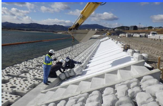
護岸施工状況
