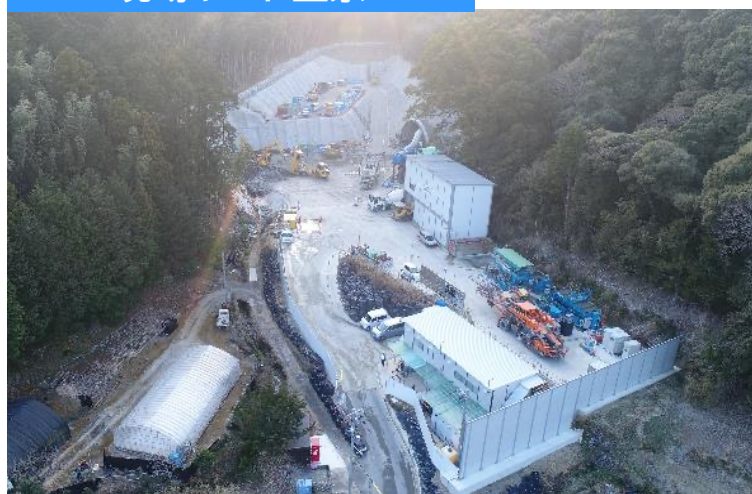
現場ヤード全景
