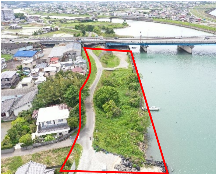
整備前(令和6年6月)
