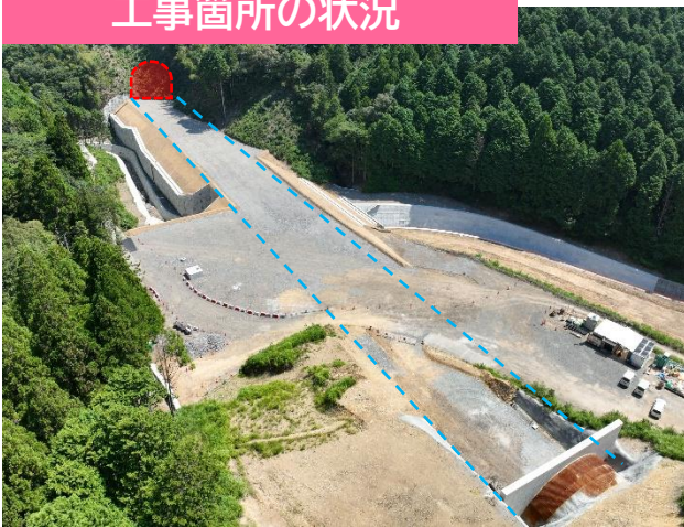
工事箇所の状況
