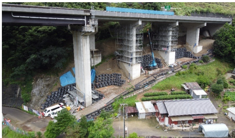
施工現場(一例)
