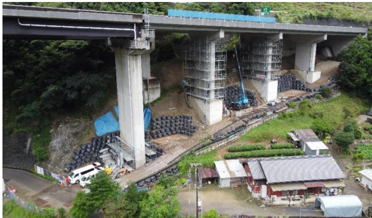
施工現場(一例)
