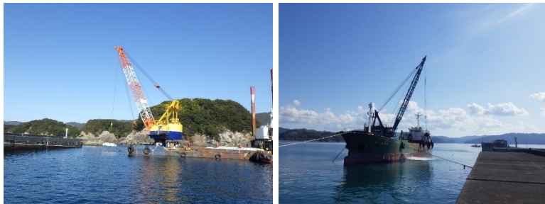
▲防波堤(Ⅰ)海上工事の様子
