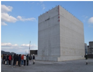
▲防波堤に使用されるケーソン
