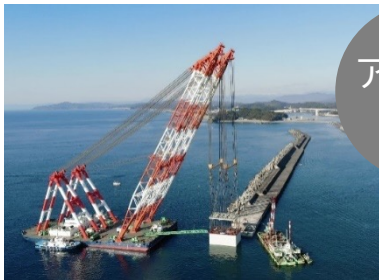
▲海上工事の様子
