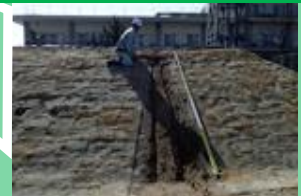
F:動物の掘返しによる変状
