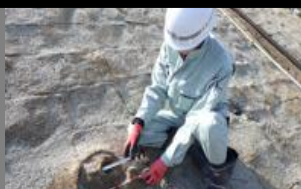
F:動物の掘返しによる変状
