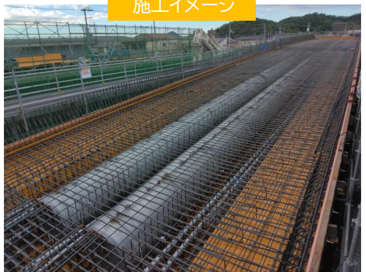
施工イメージ
