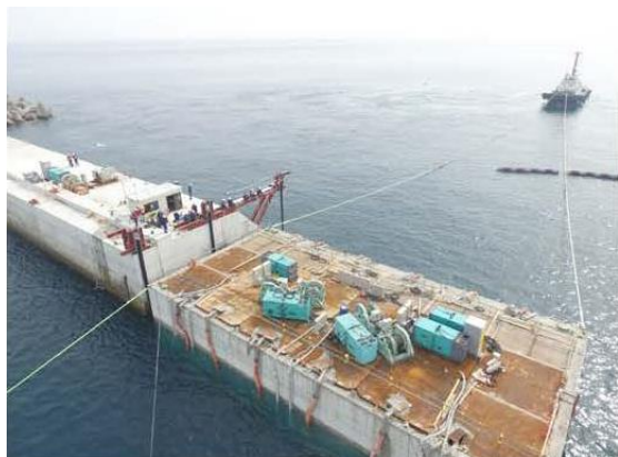
函ナビ-Autoによるケーソン据付作業 (ケーソン上に作業員なし)
