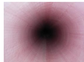
更生完了状況
