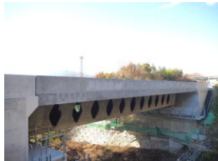
Dura-Bridge(徳島自動車道別荘谷橋)
