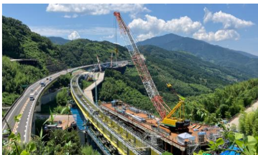
※橋梁上部工施工状況（令和5年8月）
