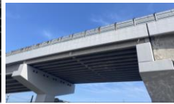
アクリルゴム系表面被覆材「アロンブルコートZ-Y・Z-X工法」
