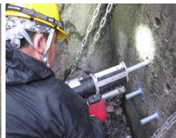
抜き取り可能なあと施工アンカーボルト「Rアンカー」
