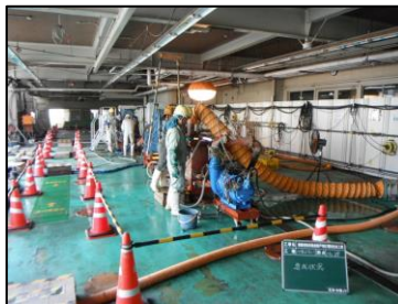
上：屋内の施工状況(JETCRETE) 下：矩形改良体(L=2.8m・t=0.85m × 2本)
