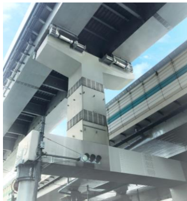
施工事例(首都高速11号台場線)
