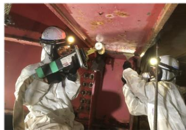
被膜除去の状況
